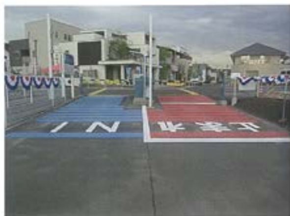
レーン明示・減速標示
