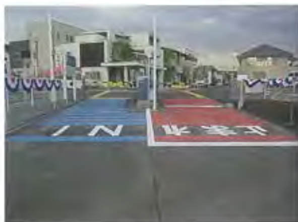
レーン明示・減速標示
