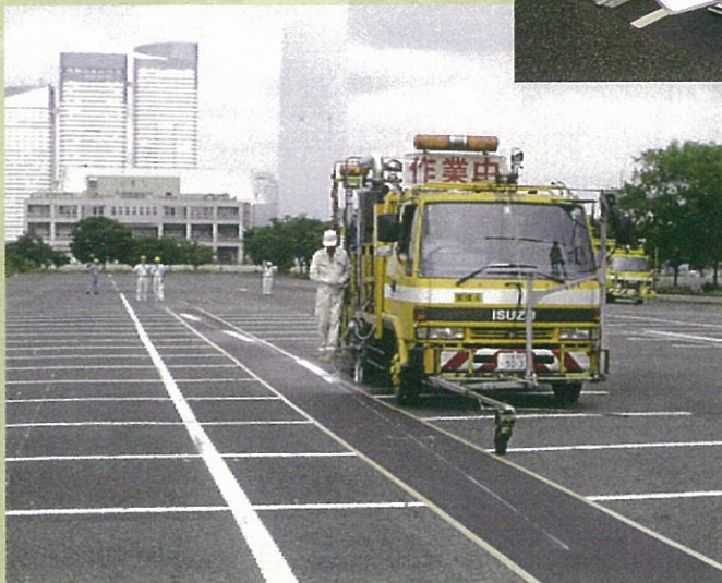
加熱ペイントマシンマーカーク工事業実技試験のようす
