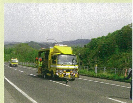
加熱ペイントマシンマーカ施工作業のようす
