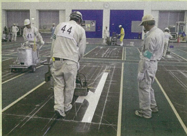
溶融ペイントハンドマーカーク工事業実技試験のようす
